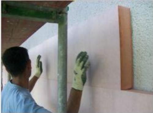
On ne peut pas vraiment éliminer les ponts thermiques, mais on travaille à les réduire. En construction neuve, il convient d'éviter au maximum les ruptures dans la continuité de l'isolant, en particulier au niveau de certaines zones qui sont particulièrement sujettes aux ponts thermiques, comme la jonction entre le mur extérieur et le plancher bas le plancher bas.
