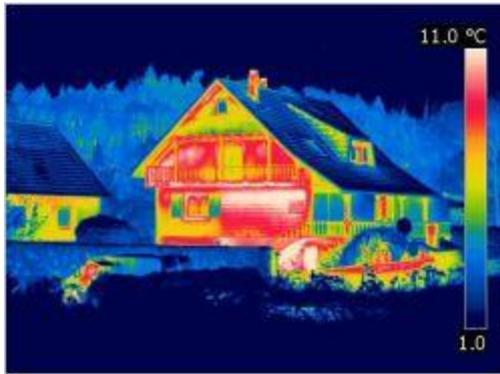
Les ponts thermiques, ces zones de déperditions de chaleur sur la structure des bâtiments, sont dans le collimateur de la nouvelle réglementation thermique (RT 2012). Présents dans la grande majorité des constructions, ils peuvent pourtant être réduits, en neuf comme en rénovation.
